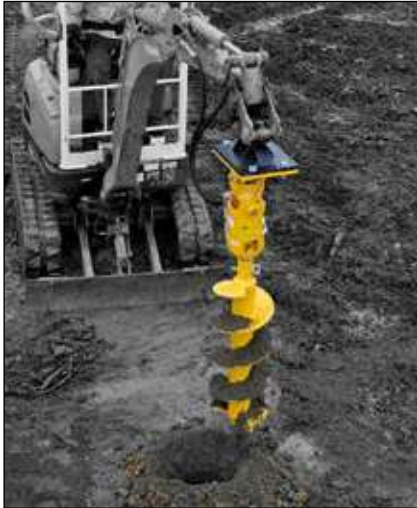
TRH 252 on mini excavator
